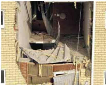
Fasaden på Järälvvägen i Linköping efter sprängningen.
